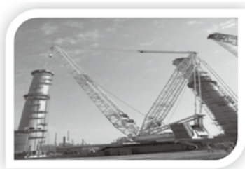
图1 大型塔器的安装与吊装
