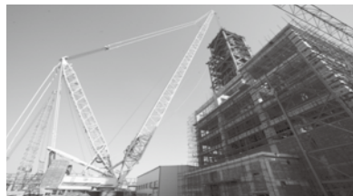
图2 大型钢结构施工现场
