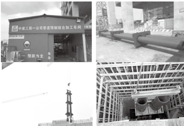
图1 装配化预制组合加工和施工现场
