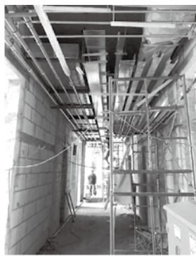
图4 走廊局部现场实际安装图
