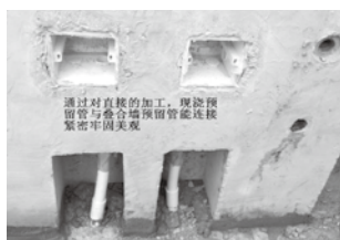
图4 打磨后PVC直接连接图
