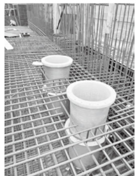
图11 FRP（玻璃钢）直埋管道安装现场（垂直方向）
