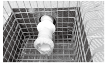
图9 FRP（玻璃钢）直埋管道安装现场（水平方向）
