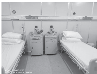
图8 设备带模块及安装实例
