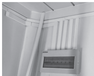
图9 顶板内提前敷设回路电线及户内箱安装实例
