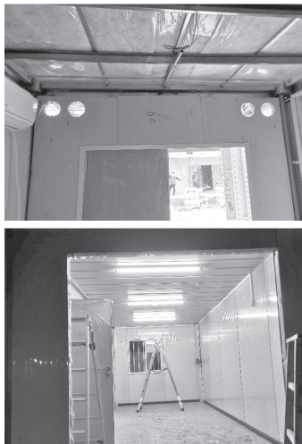
图10 灯具电源线提前敷设及病房模块就位后的灯具安装
