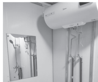
图5 热水器安装示意图及安装实例
