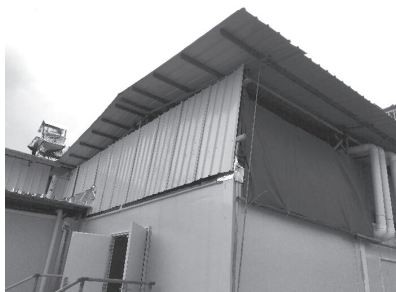
图4 加盖屋面雨棚形式
