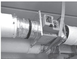
图4 方形电动密闭阀连接实例
