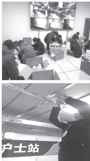
图3 提前记录IMEI码及无线烟感安装
